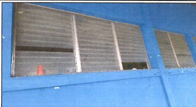
Foto 2: REPOSICIÓN DE VENTANAS Y COLOCACIÓN DE BALCONES
