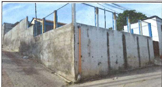
Foto1: PINTURA DEL MURO PERIMETRAL
