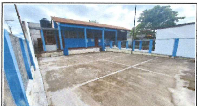
Foto 3: PINTURA DE PAREDES Y MURO PERIMETRAL
